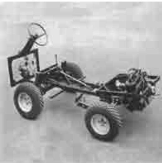
Sopra, telaio del 4x2 (Quattroruote febbraio 1968).
